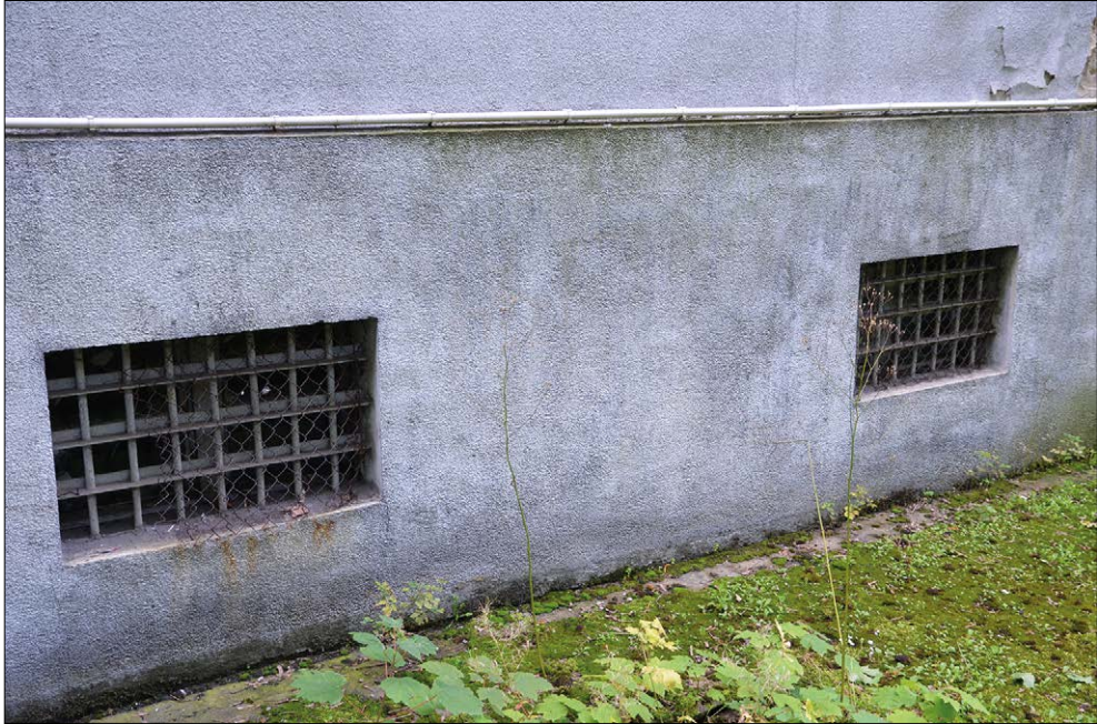
Ryc. 3. Okna piwnic dawnego budynku PUBP/PUdsBP w Stargardzie przy ul. Stefana Czarnieckiego 30-31, wg stanu z 2012 r. Fot. A. Bierca, zbiory MAH w Stargardzie
